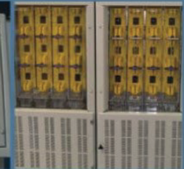
Bases NH tripolares para seccionamiento
