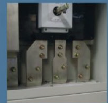
Seccionador rotativo
